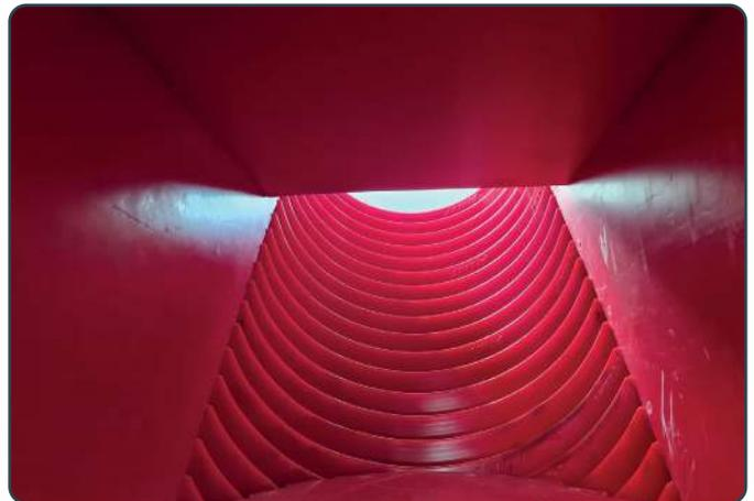
SZ-Platten als Auskleidung in einem Auslauftrichter in Verbindung mit PUCEST Platten.
