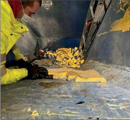
Die Abbildungen zeigen das sehr aufwendige und mühsame Entfernen einer gänzlich ungeeigneten Sprühbeschichtung eines Trichters.
