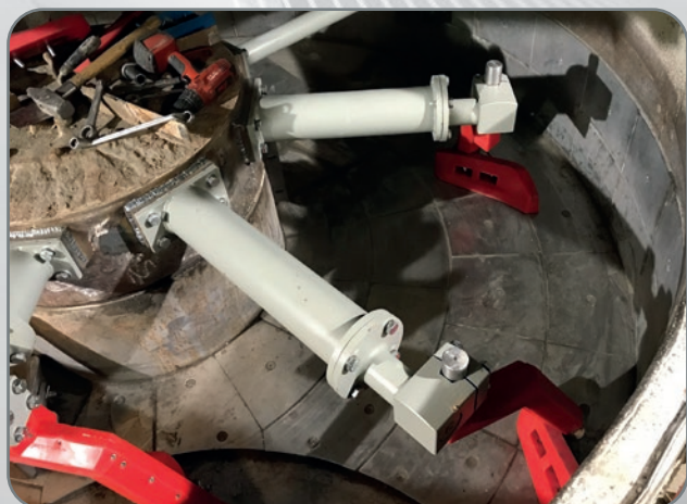
Nach dem Umbau - ein komplett neuer Mischer ist einsatzbereit
