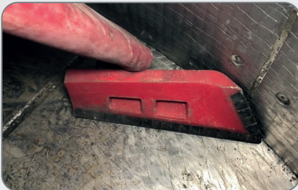
Einbau der Schaufel am 12.04.2023
