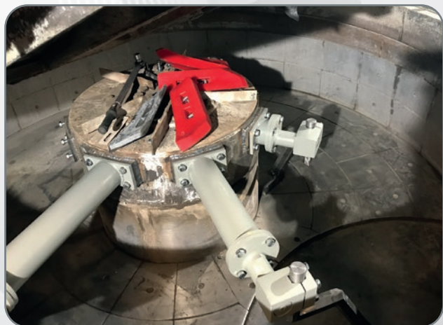
Während der Umbauarbeiten
