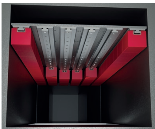
Die Modul-Bausteine im verschlissenen Zustand
