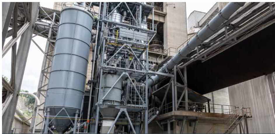
Vorderansicht der Anlage. Links im Bild das Silo mit dem Rohmaterial. In der Mitte die Zykclone und die Brennkammer. Rechts der Drehrohrofen und die Leitung für die Klinkerkühlerabluft. © Rohrdorfer Unternehmensgruppe
