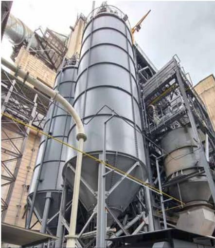
24 Meter hoch ragt die neue Versuchsanlage in die Höhe. Im Siloturm befindet sich das Rohmaterial. © Rohrdorfer Unternehmensgruppe
